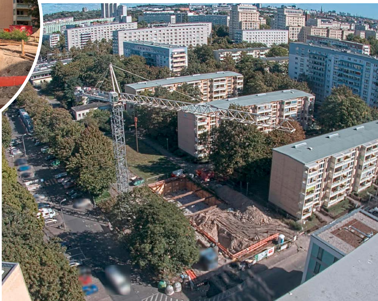
Baustelle mit Stand des Aushubs (24.09.2025)
