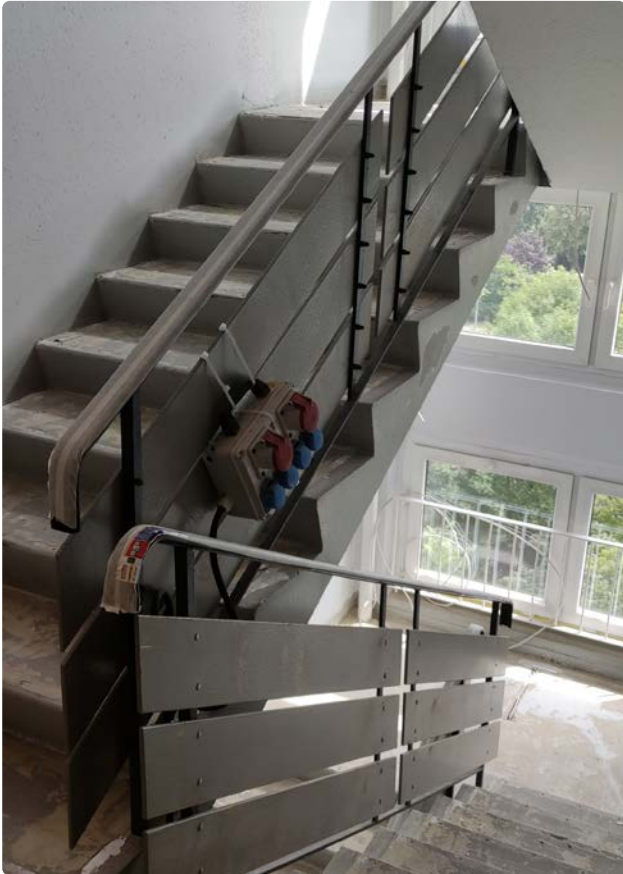
Treppenhaussanierung Am Tierpark (Bauphase)
