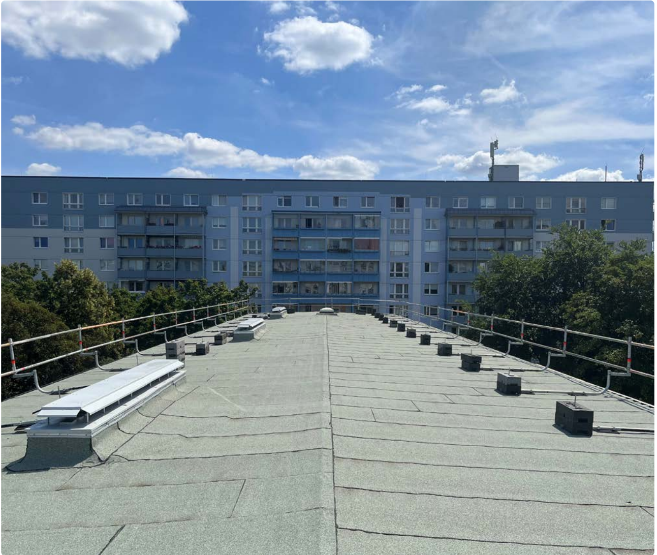
Schillingstraße 3–6 nach der Sanierung
