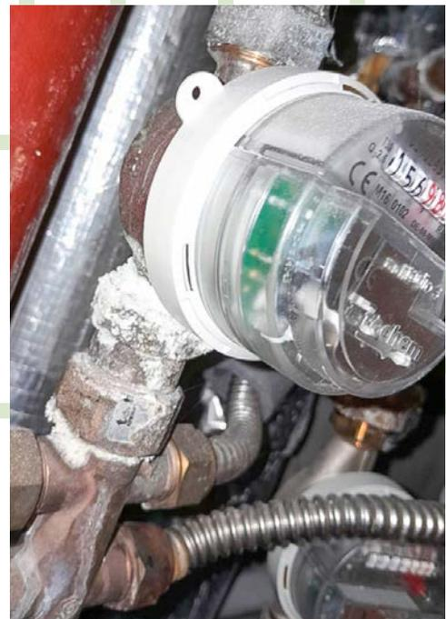
*Anlagen in unterschiedlichen Mängelstadien. Korrodierte Anschlüsse an der Wasserverteilung.*
