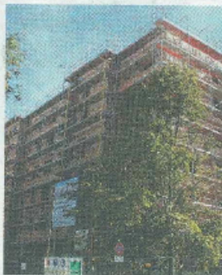
Blick auf den Rohbau des Mehrfamilienhauses in der Massower Straße.
