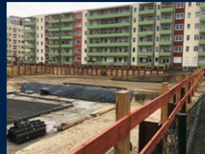
Blick auf die Baustelle, Stand Dezember 2018
