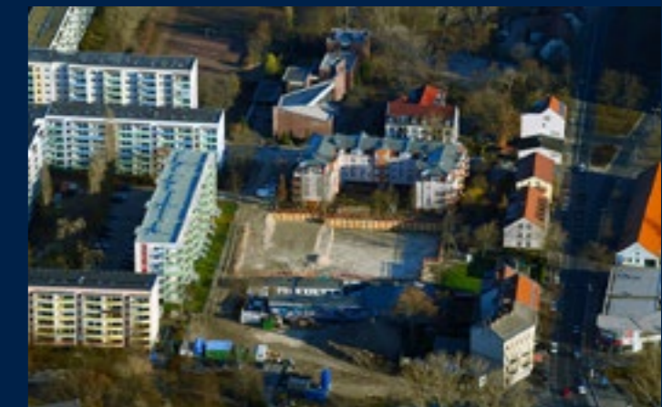
Luftbild vom Baufeld, Neubau
