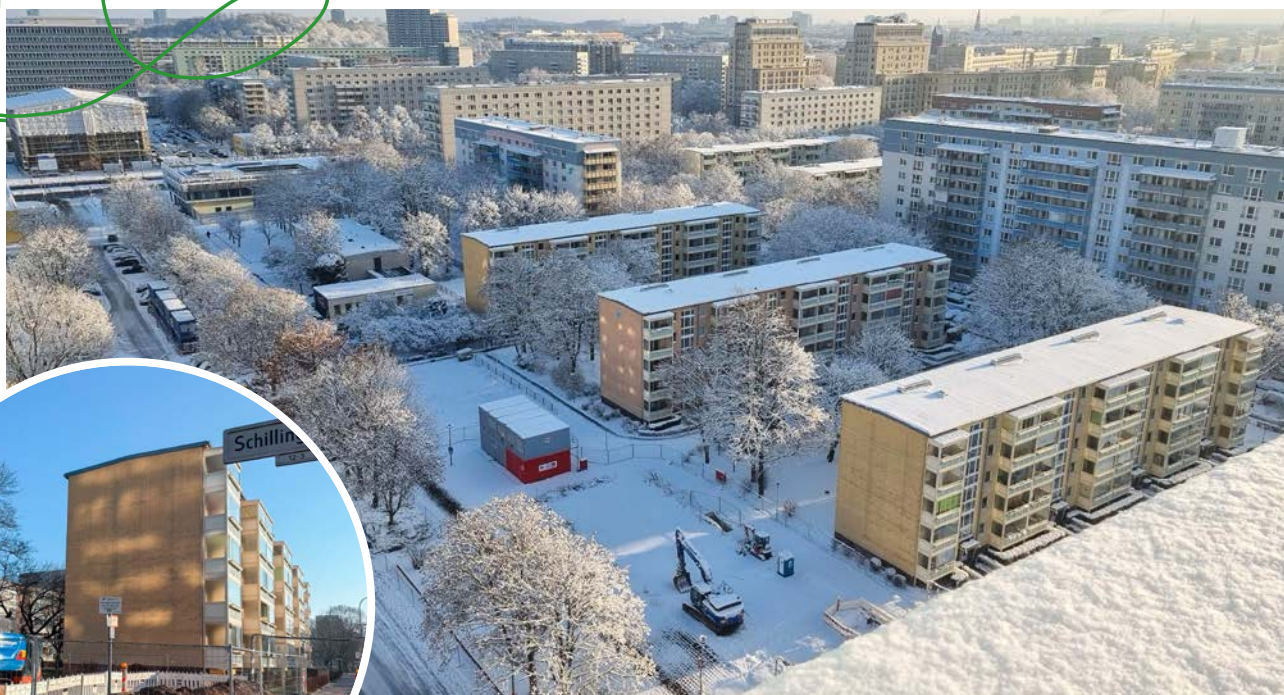
Baustelle Schillingstraße & Ansicht von oben im Winter
