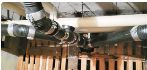
Projekt 2023: Ablagerungen in den Abwasserleitungen vor der Instandsetzung (oben) und verlegte Leitungen danach (unten)
