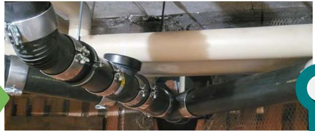
Projekt 2023: Ablagerungen in den Abwasserleitungen vor der Instandsetzung (oben) und verlegte Leitungen danach (unten)
